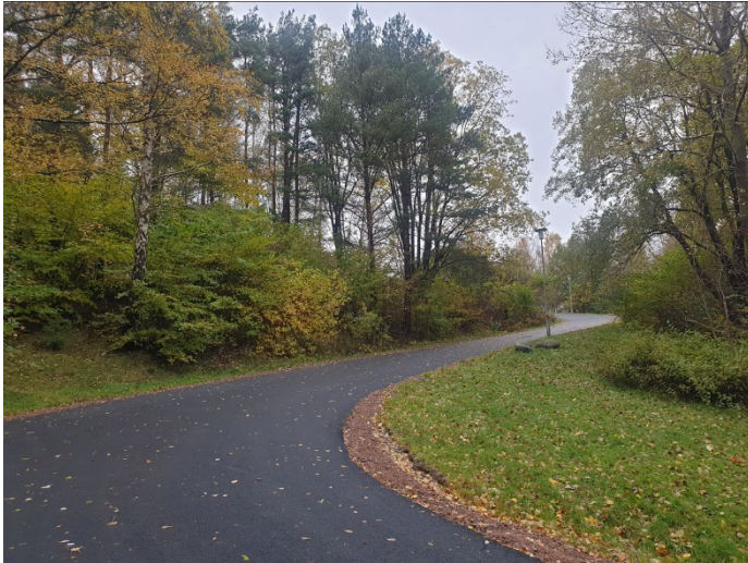
Figur 9. Ryndbacken, vy upp mot Stjärnbildsgatan, lutning 13%. Marknivån föreslås sänkas för jämna ut lutningen och möjliggöra förtätning med bostäder längs stråket.
